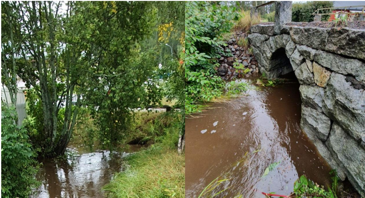
Figur 5 Bild från vägtrumma (foto uppströms) vid Vågbrovägen och vid stenbron nedströms vägen (foto nedströms) den 18 augusti kl. 09:30 när den maximala vattennivån uppnås under flödestoppen. Den momentana vattenföringen är 1,2 m 3 /s.
